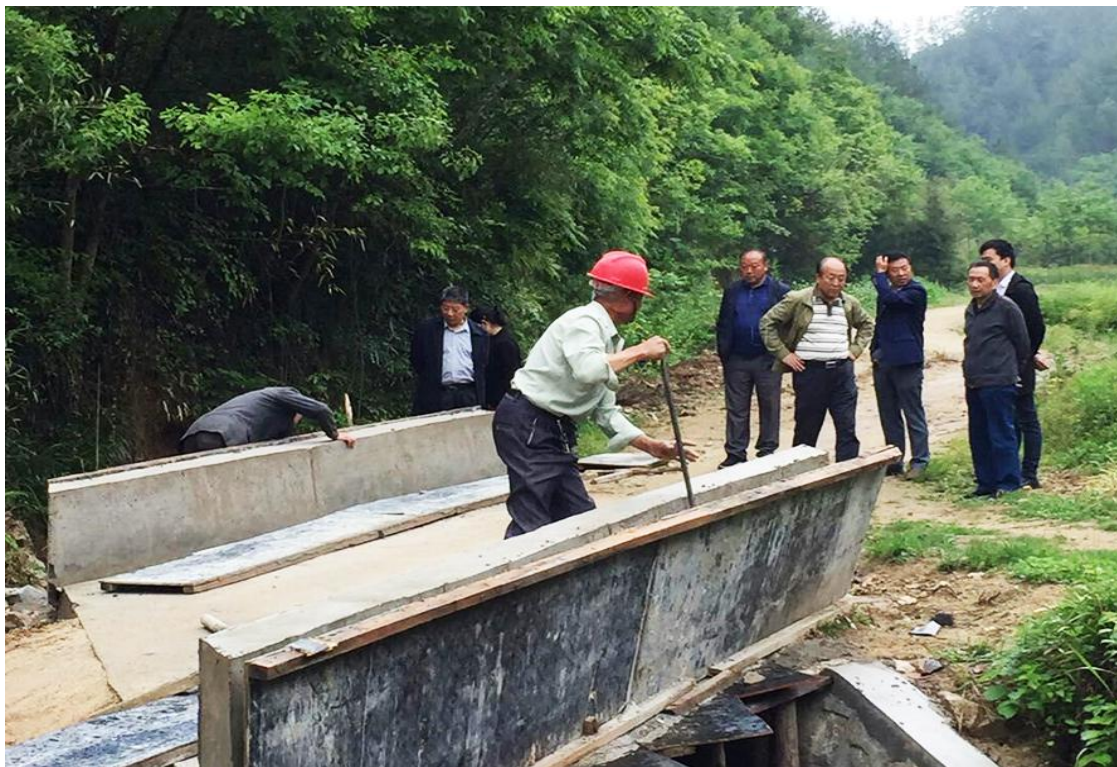
(图为：刘润民会长（右四）检查正在施工的慈安桥)
