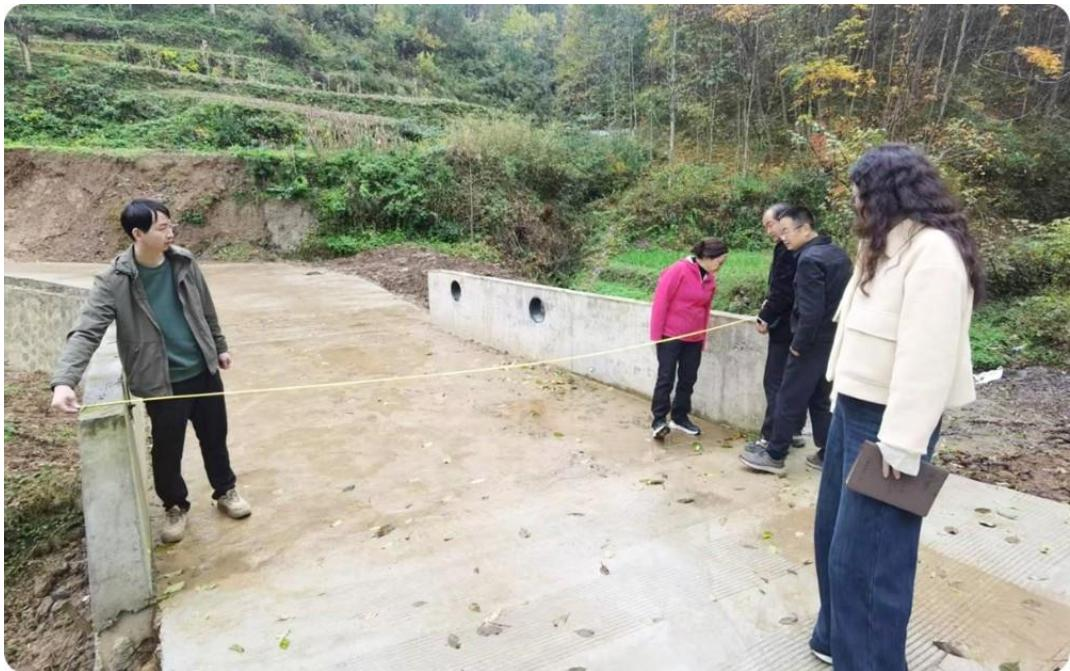
验收现场，工作人员严格对照项目建设标准，对桥梁基础挡墙、结构稳固性、承重能力、护栏防护等关键指标逐一细致核查，对发现的细节问题现场反馈并下达限期整改通知，确保每一座桥梁都经得起实践和时间的检验。项目建设期间，县慈善协会精准对接群众需求，
