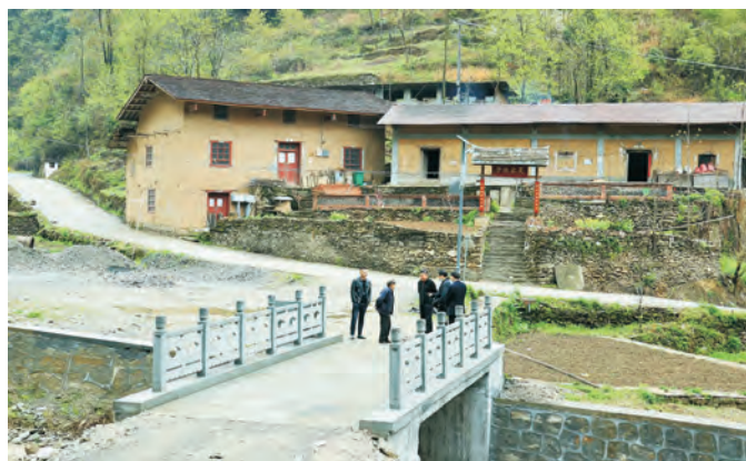
茨沟镇瓦铺村慈安便民桥
