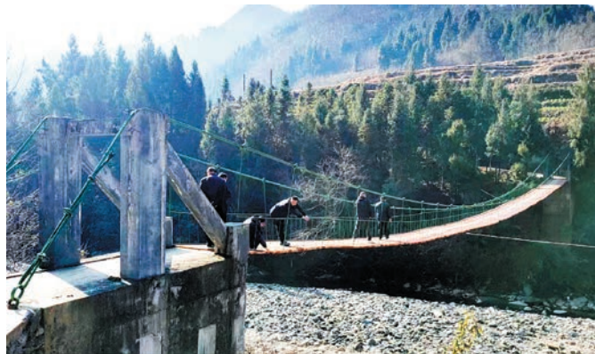
汉阴县漩涡镇钢索人行吊桥
