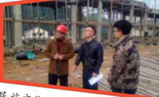
民族文化广场廊桥建设中
