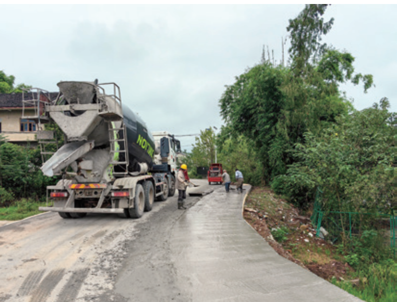
正在施工中的村路拓宽现场
