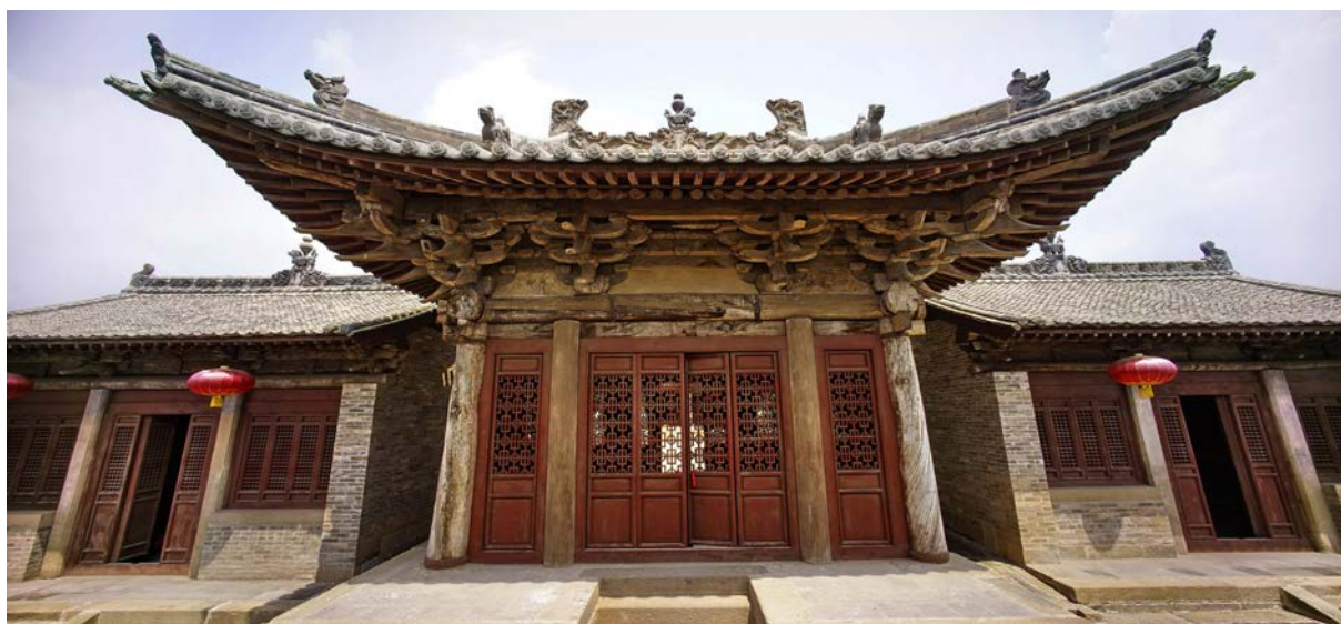
炎帝中庙无梁殿
